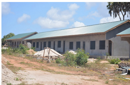
Ujenzi wa Shule ya Msingi mpya Gezaulole
